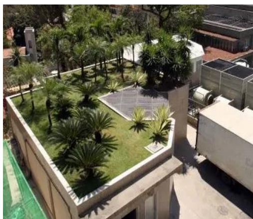
Figura 2 - Telhado Intensivo/Hospital São Vicente de Paulo- RJ
